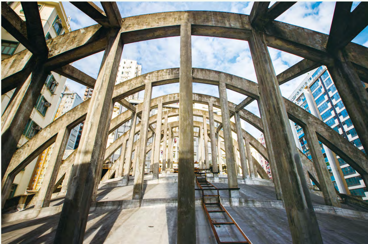
皇都戲院具標誌性的拋物線型拱橋式桁架
